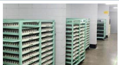
콘크리트 격벽 설치, 전지 분산 보관
