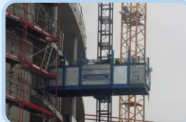
리프트 출입문 및 안전난간을 시스템 비계와 일체화 시공
