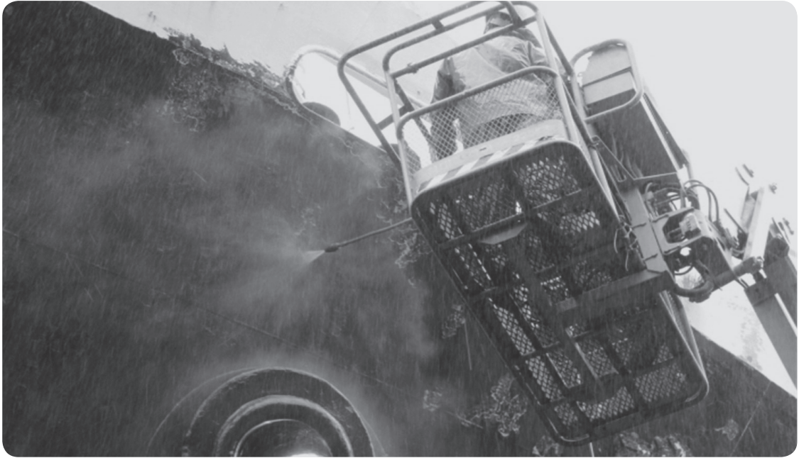
사진 5 고압세척기 작업 모습(고소작업자 이용)
