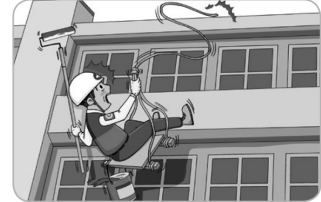
달비계를 사용하여 건물 외벽 청소시 구멍줄 미설치
