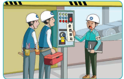
3 기동장치 잠금조치, 표지판 설치
