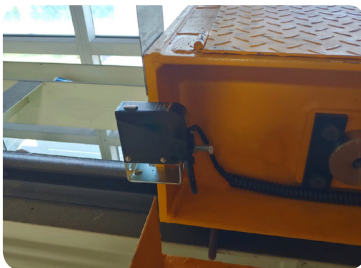
주행레일 리미트 스위치 (지상) 크레인이 차륜정지기구 도달 전 리미트스위치의 작동여부 확인
