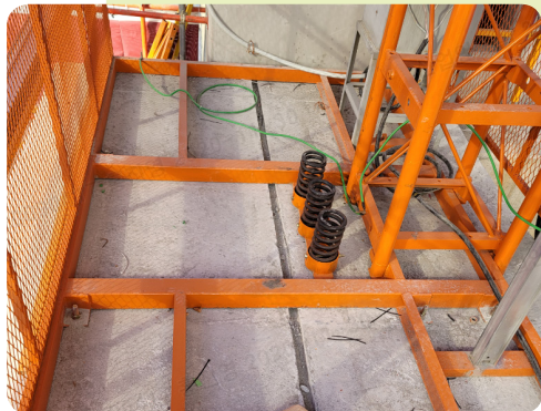
기초부 바닥 배수 및 베이스설치상태
