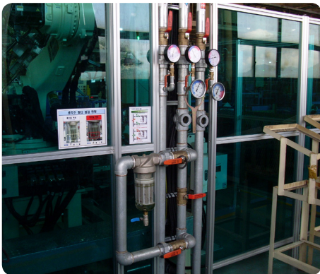
조작밸브가 보호영역 내부에 있으나 보호영역 외부에서 안전한 조작이 가능한 구조이므로 인정가능
