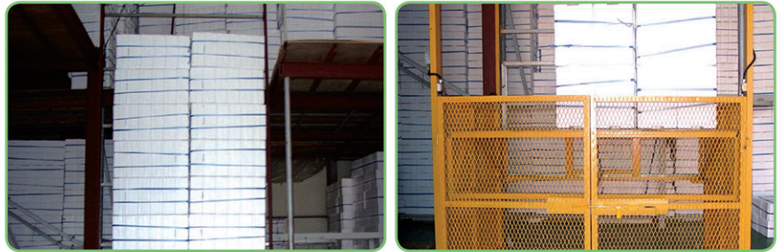
일반작업용 리프트에 출입문 연동장치 및 방호울 설치로 끼임 및 물체에 맞음 재해예방
