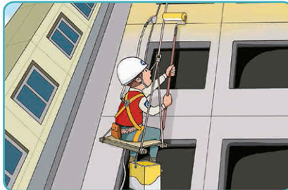
5 달비계 작업 시 안전대 및 구명줄 설치
