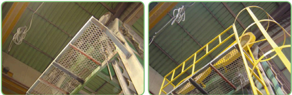
추락위험 장소에 안전난간 및 사다리를 설치해 추락재해예방
