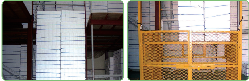
일반작업용 리프트에 출입문 연동장치 및 방호울 설치로 끼임 및 물체에 맞음 재해예방
