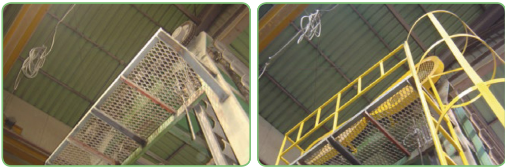
추락위험 장소에 안전난간 및 사다리를 설치해 추락재해예방
