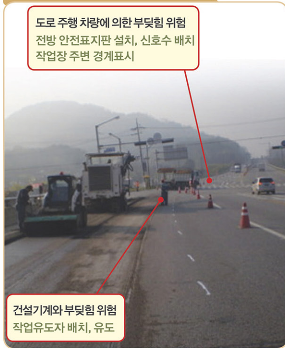
도로 유지, 보수 공사
