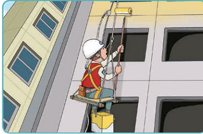
5 달비계 작업 시 안전대 및 구명줄 설치
