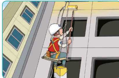
5 달비계 작업 시 안전대 및 구명줄 설치
