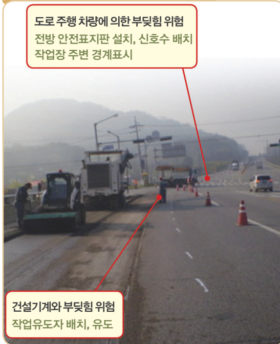
도로 유지, 보수 공사
