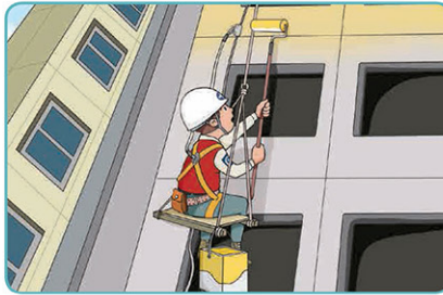
5 달비계 작업 시 안전대 및 구명줄 설치
