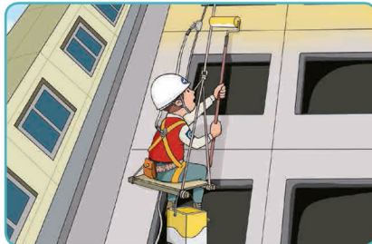
5 달비계 작업 시 안전대 및 구명줄 설치
