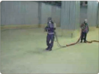
냉동창고 벽면·바닥 스프레이 시공
