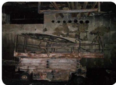
가설전등 스파크로 인한 우레탄폼 화재로 13명 사상
