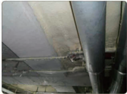
일반 건축물 천정부 스프레이 시공
