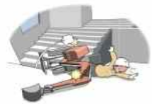
작업 중 굴착기가 넘어지면서 운전석에서 이탈한 운전자 깔림
