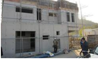
작업발판·안전난간·계단 미설치
