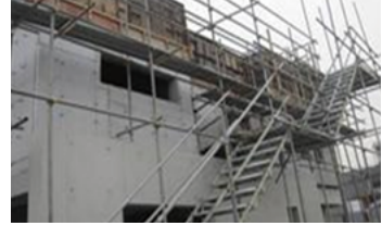
작업발판·안전난간·계단 설치
