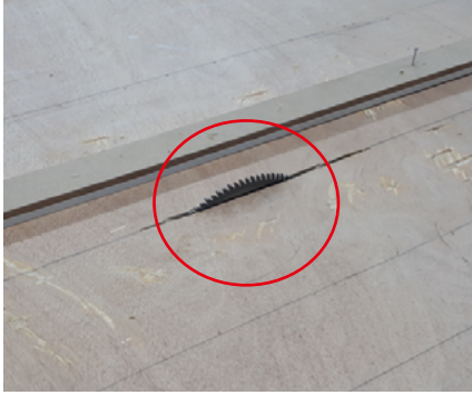
목재가공용 둥근톱 날접촉방호덮개 미설치
