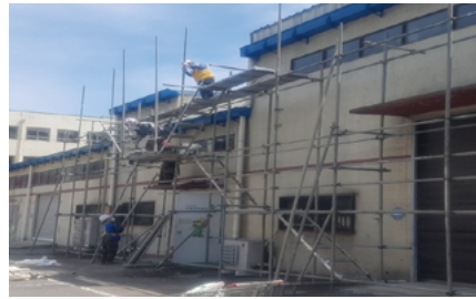
쌍줄비계 조립 작업 시 작업발판을 설치하고 안전대 착용
