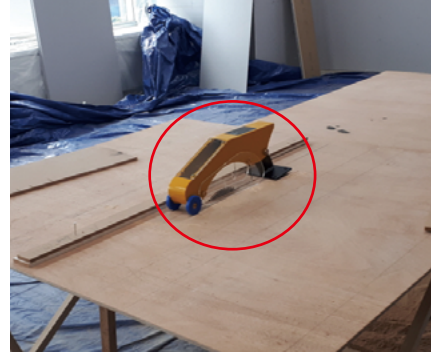
목재가공용 둥근톱 날접촉방호덮개 설치
