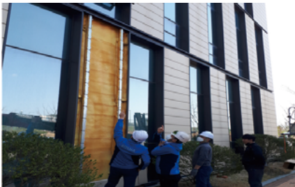
외벽 경질우레탄폼 주변 배관 용접 작업 시 화재 위험
