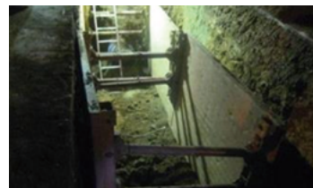
트렌치굴착 흙막이보공 설치
