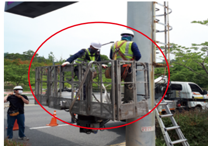
고소작업대 교체(안전난간 설치)
