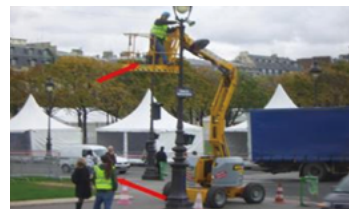
가로등·신호등 작업발판 설치
