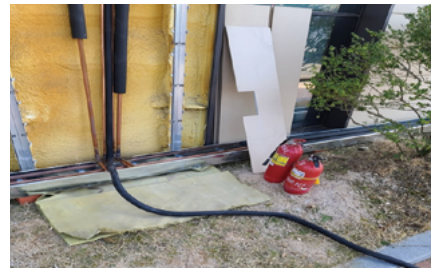
용접 불티 비산방지포 설치 및 소화기 비치
