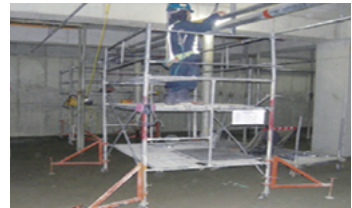
상부작업대 안전난간 설치
