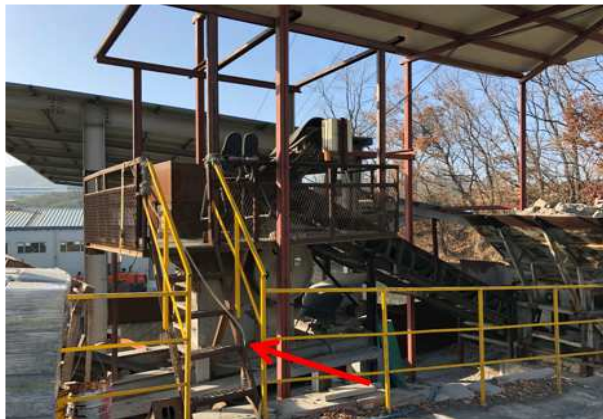
지상에 설치된 조작실 이동을 위해 계단 설치
