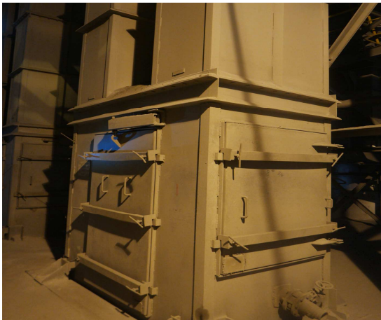
버킷 컨베이어 케이싱 점검문
