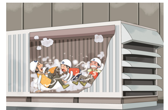
- 냉각탑 내부 내장재(충전재) 교체 작업을 하던 중 냉각탑 내부로 유입된 질소에 의해 질식 4명 사망
