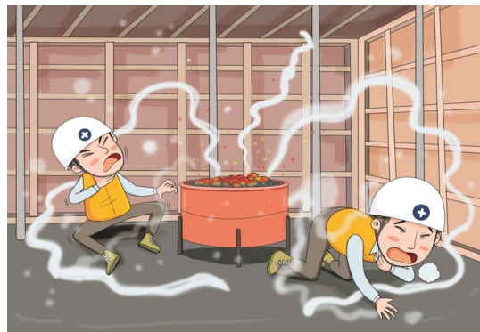
- 콘크리트 양생 고체연료를 교체하기 위해 현장에 들어갔다 일산화탄소 질식 2명 사망
