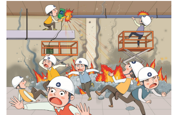
- 건물지하 설비공사현장에서 다수 하청근로자가 동시 작업 중 용접불티에 의한 화재 8명 사망
