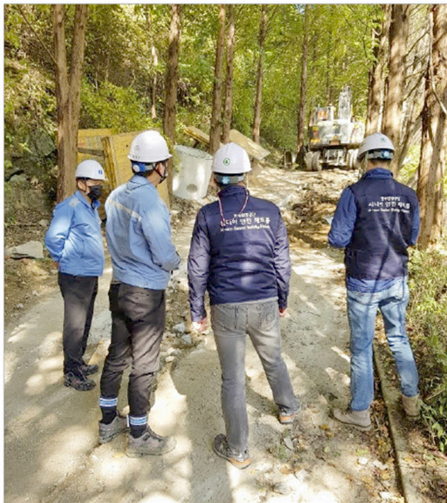
01-02 건설현장 불시 점검에 나선 시니어 안전 패트
