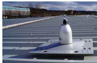
<그림 7> 경사진 지붕에서의 안전대 부착설비 설치 예
