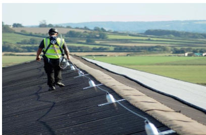
<그림 7> 경사진 지붕에서의 안전대 부착설비 설치 예
